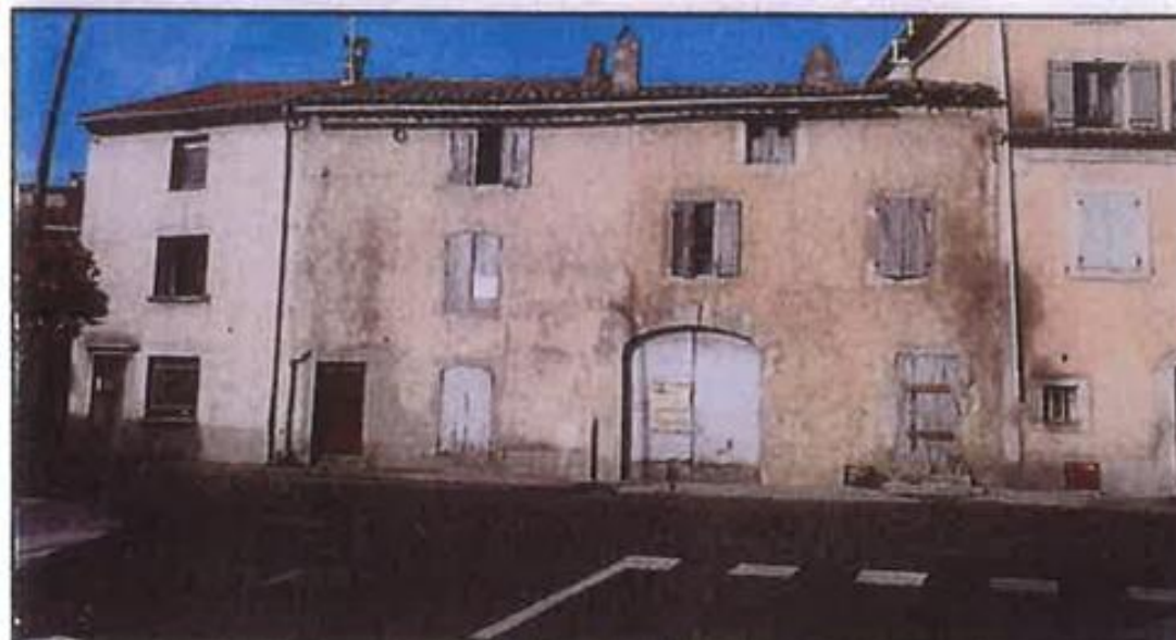
Façade SUD existante
